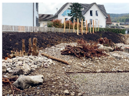
Hintergrund: Pfähle für die Benjeshecken, diese werden mit Ästen aus der Rodung aufgefüllt.
